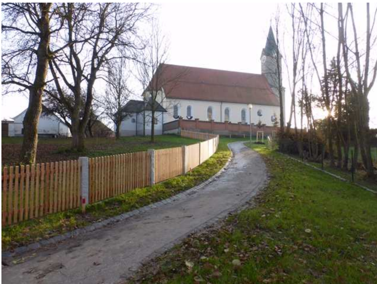
Erneuerung des Kirchenaufgangs im Rahmen der Dorferneuerungsmaßnahme Moos 2016
