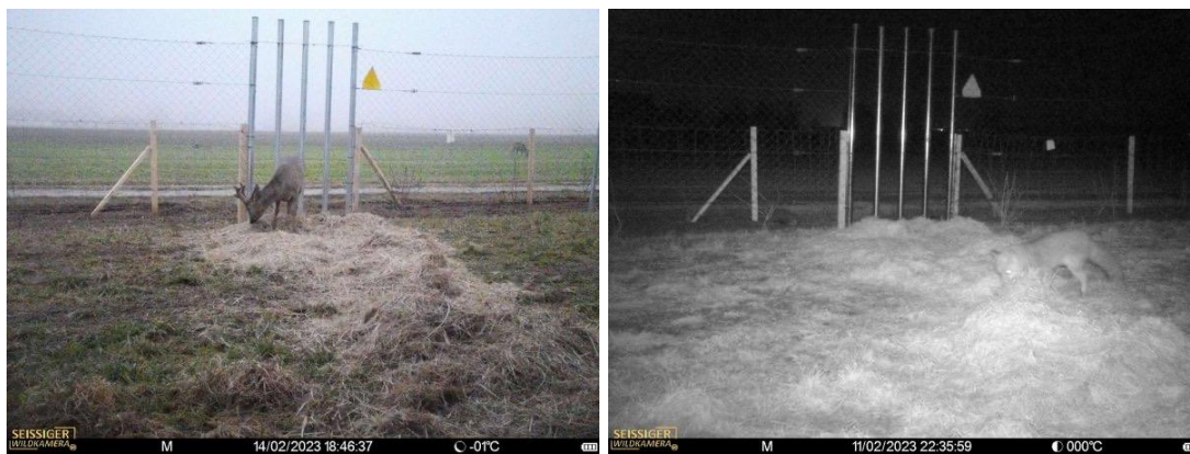
Wilddurchlässe in der Freiflächenphotovoltaikanlage „Burgstall West“
