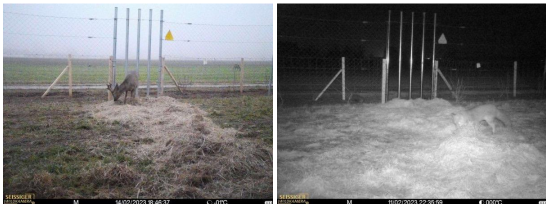
Wilddurchlässe in der Freiflächenphotovoltaikanlage „Burgstall West“
