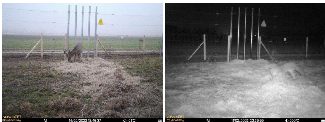
Wilddurchlässe in der Freiflächenphotovoltaikanlage „Burgstall West“
